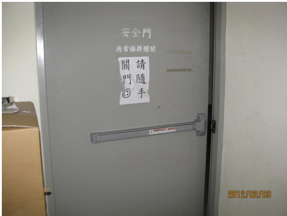
B棟4樓防火逃生門(無法閉合)
