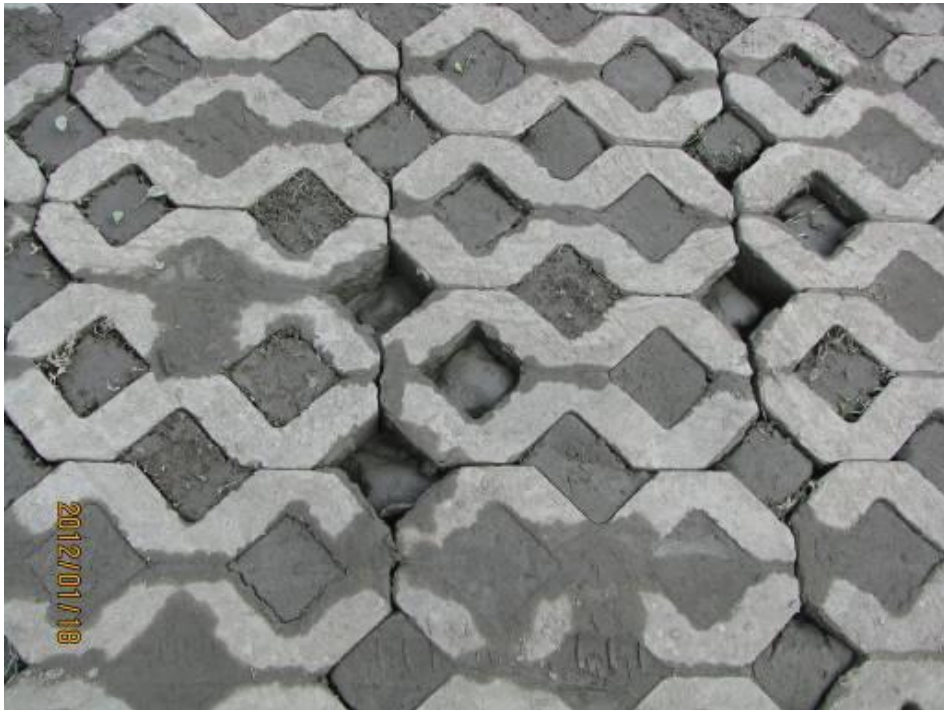
地坪土壤流失淘空-2
