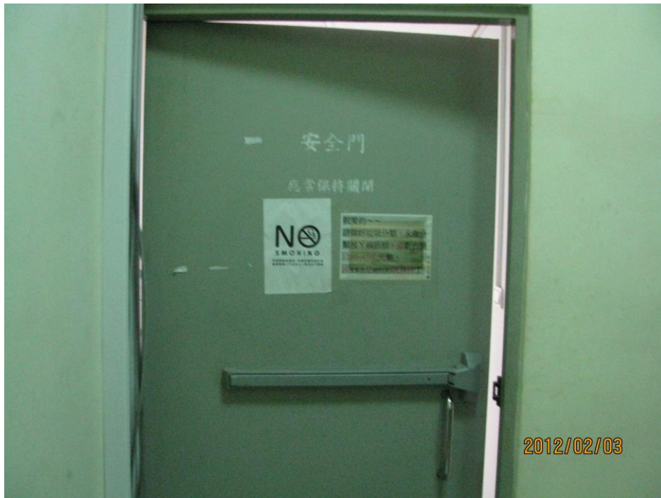
B棟2樓防火逃生門(無法閉合)
