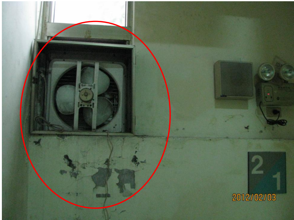
雨水滲入積水及牆面污損—6
