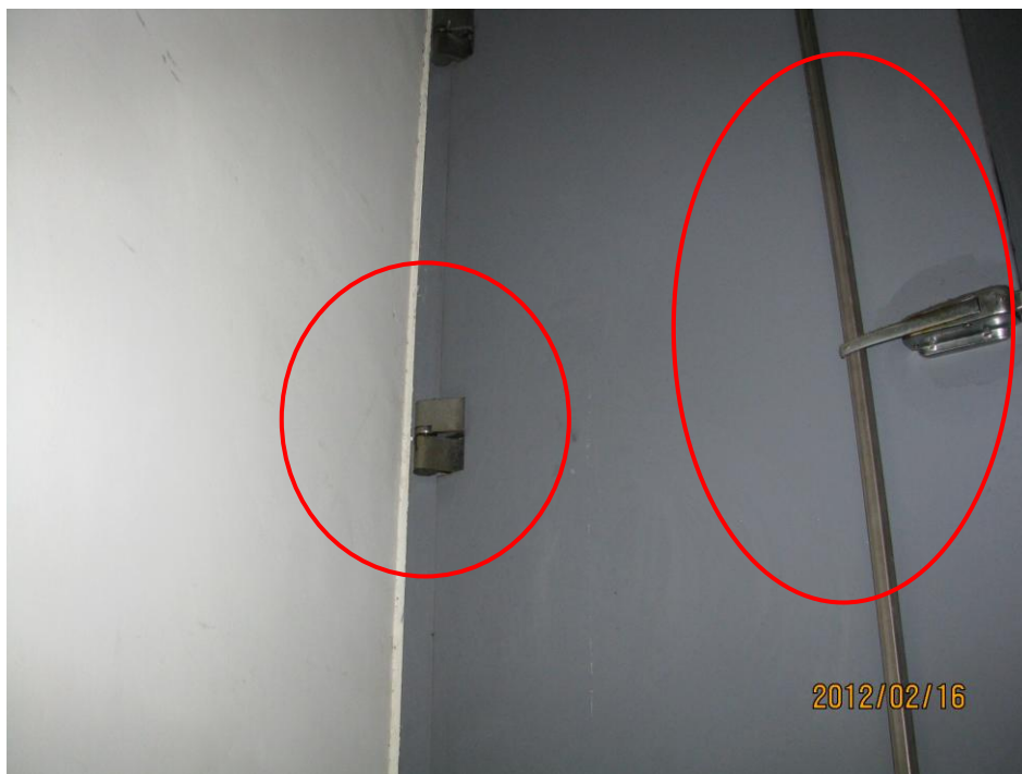
B棟1樓第2攝影棚隔音門軸、門栓異常
