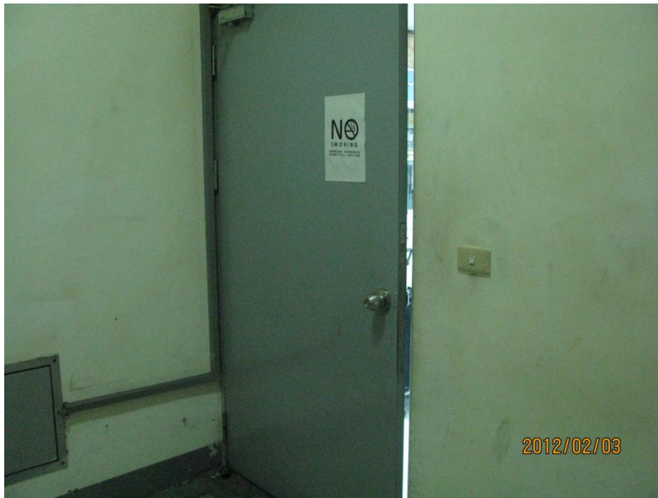
B棟3樓防火逃生門(C梯無法閉合，油煙溢入節目部)
