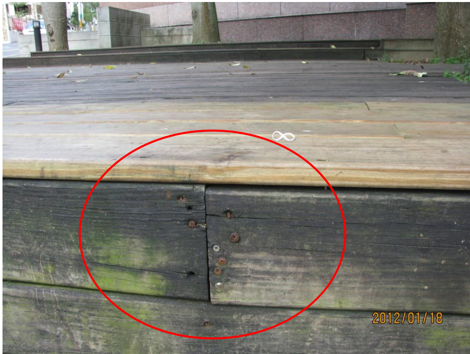
鐵釘固定困難(骨架鏽蝕)
