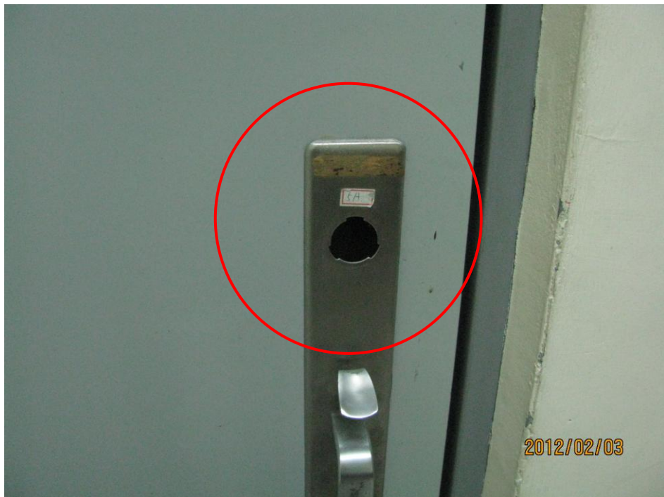
A棟5樓防火逃生門(門鎖掉落)
