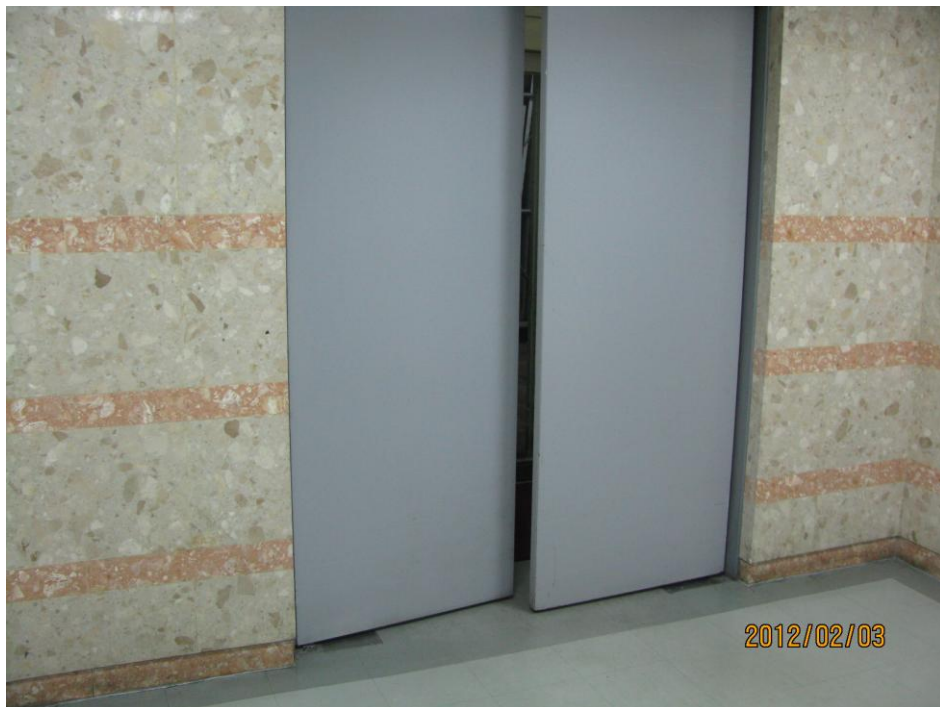
A棟地下2樓防火門(無法閉合)
