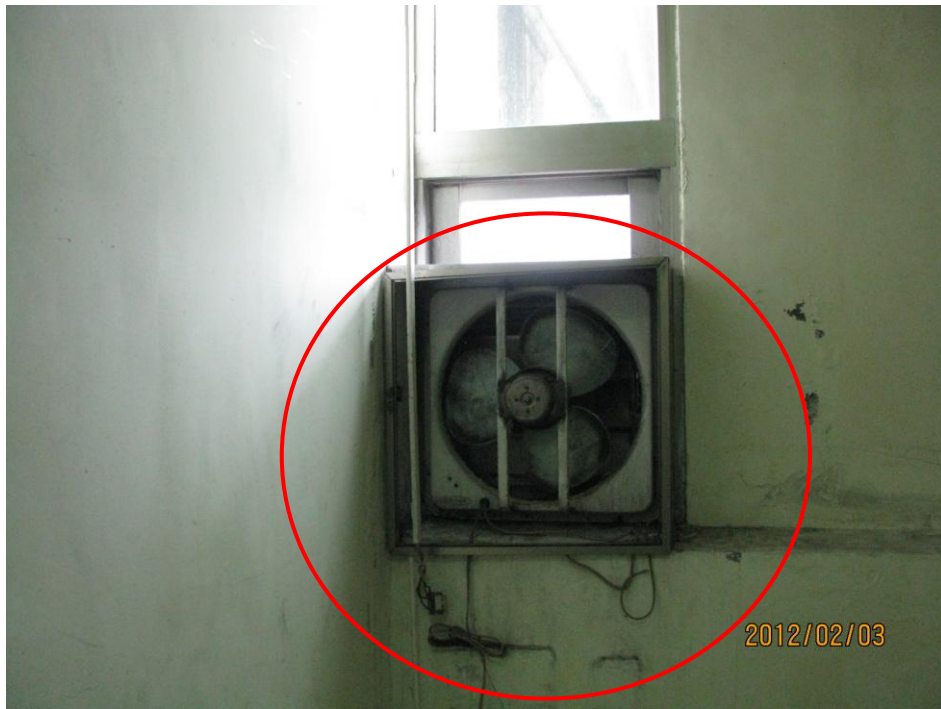
雨水滲入積水及牆面污損-3
