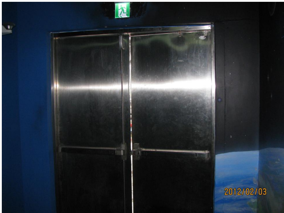
B棟頂樓防火逃生門(無法閉合)
