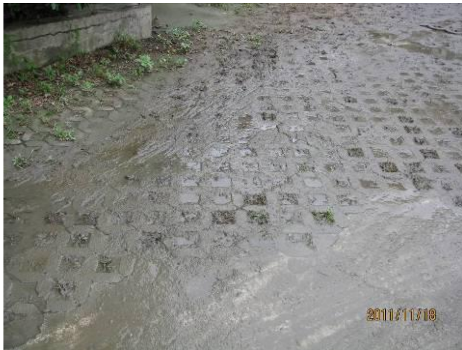
地坪積水泥濘情形-1
