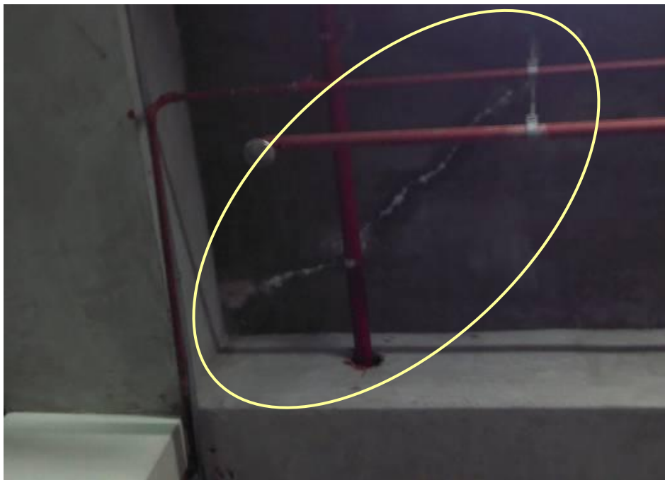
0B 車庫天花板漏水(停車場下層)-2 (裂縫漏水)
