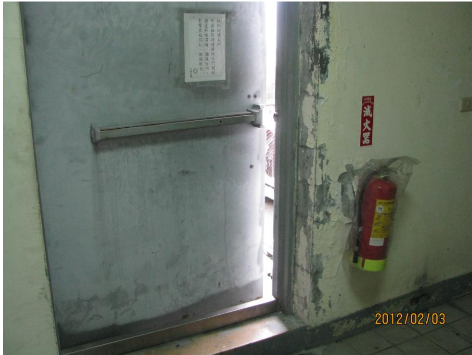
A棟頂樓防火逃生門(無法閉合)-1
