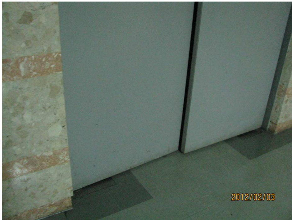
A棟3樓防火門(無法閉合)
