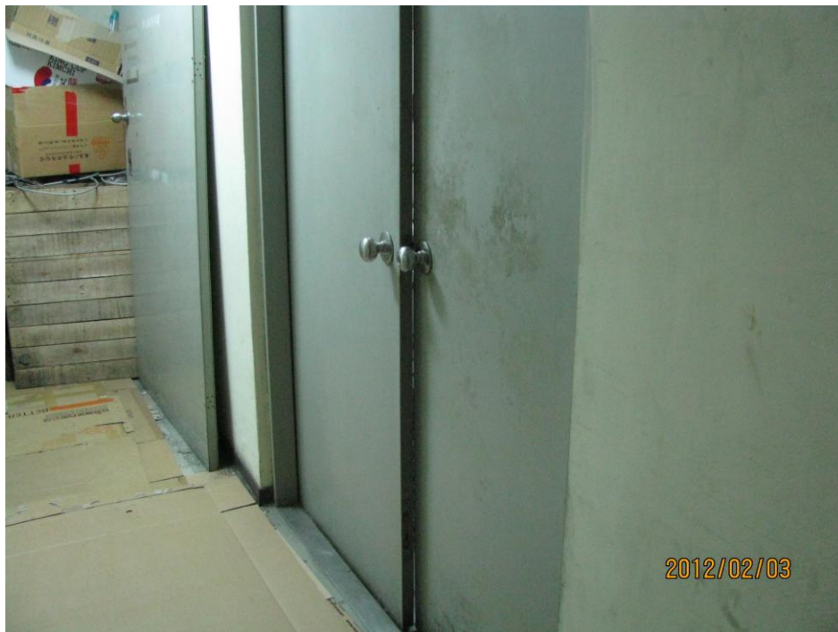
B棟4樓廚房防火門(C梯無法閉合，油煙溢出)
