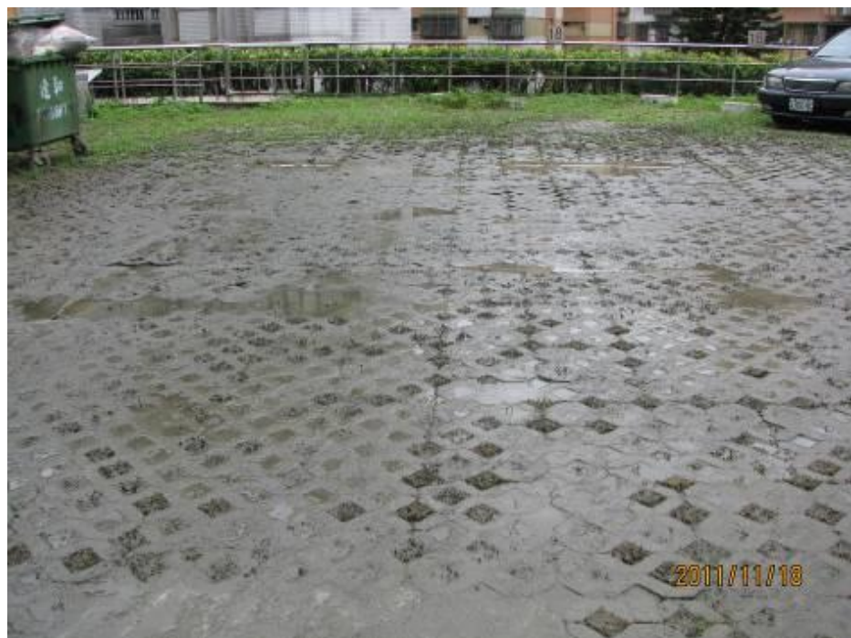
地坪積水泥濘情形-2
