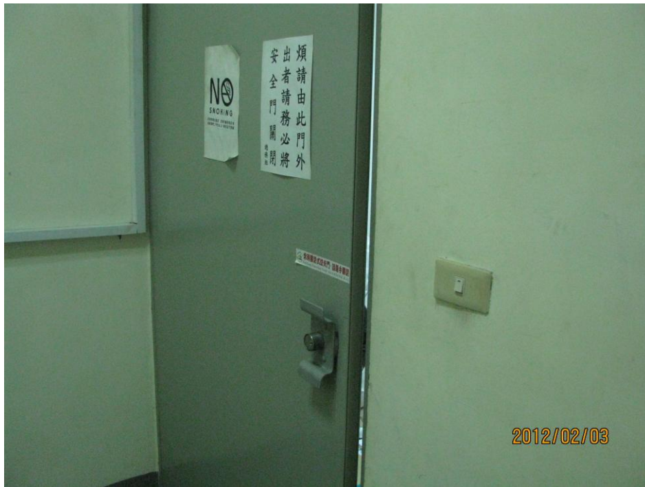
B棟4樓防火逃生門(C梯無法閉合，油煙溢出)
