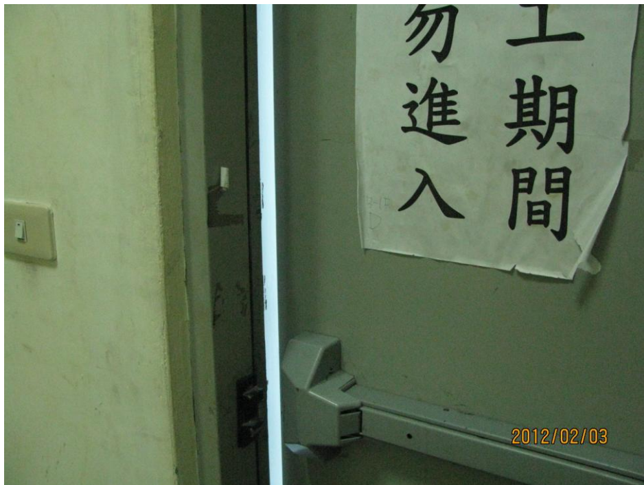
B棟1樓防火逃生門(無法閉合)-3
