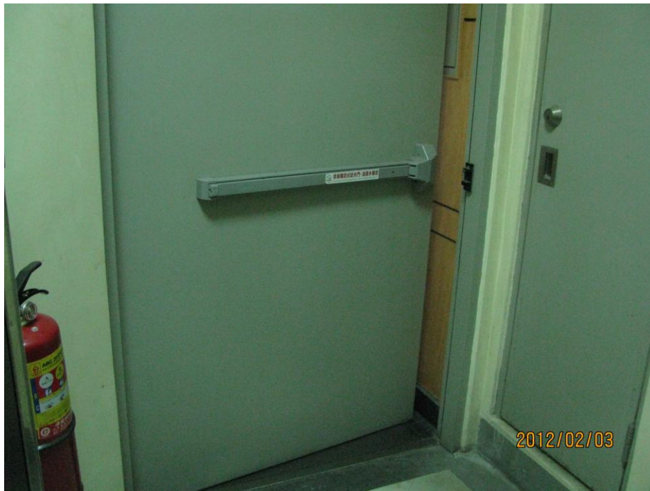
B棟4樓防火逃生門(無法閉合)
