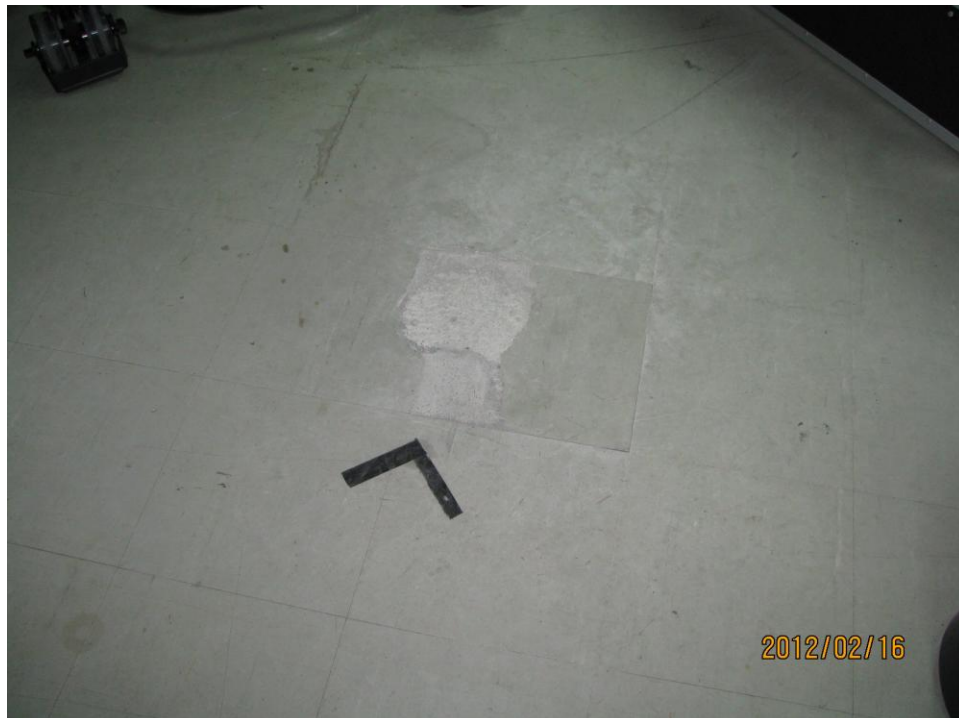
A棟地下2樓第5攝影棚攝影機庫房塑膠地板破損
