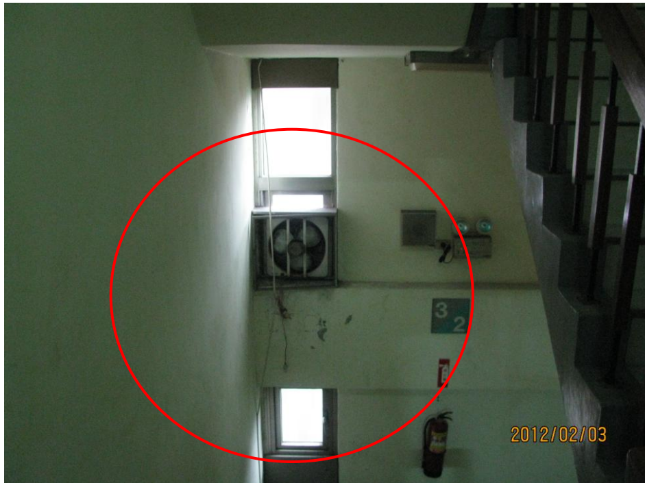
雨水滲入積水及牆面污損-4
