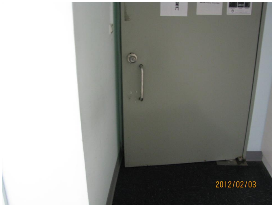
B棟1樓防火逃生門(下垂卡死，無法閉合)-1
