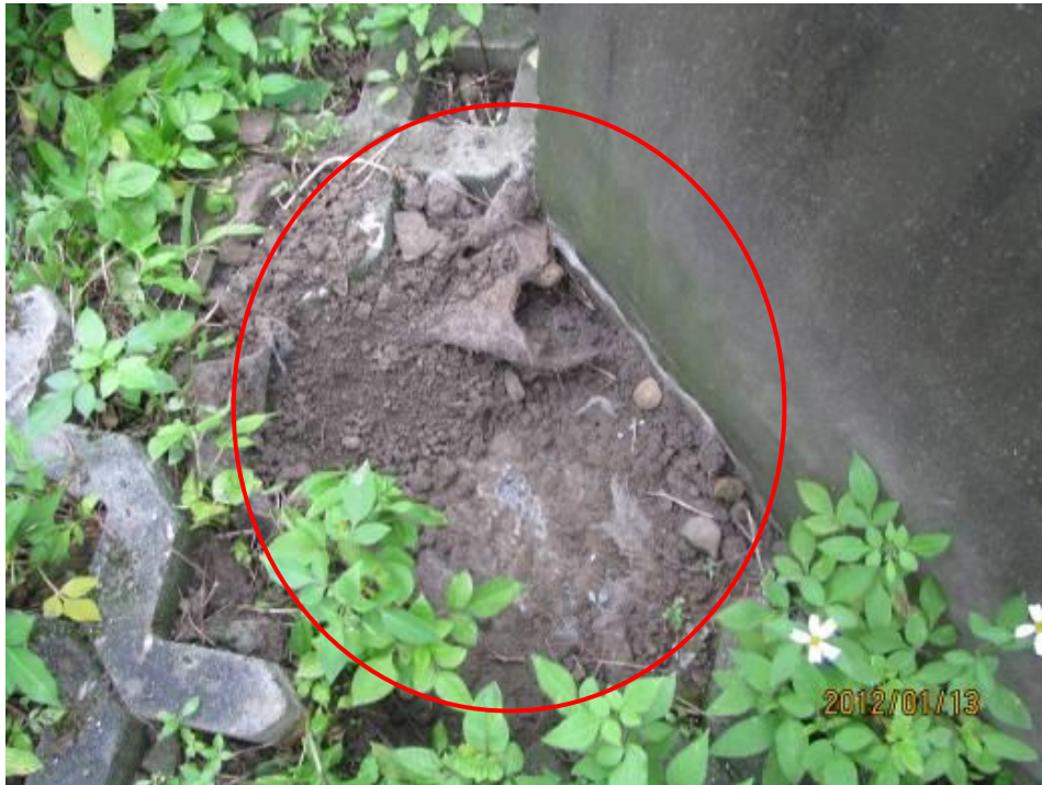
地坪底部防水層破損-1
