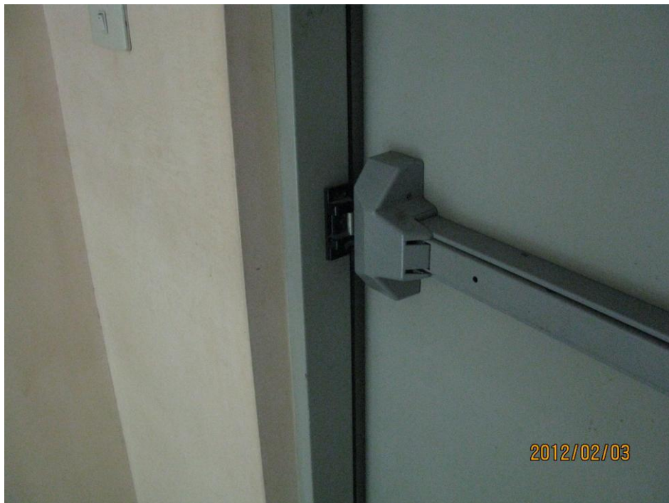
B棟5樓防火逃生門(無法閉合)
