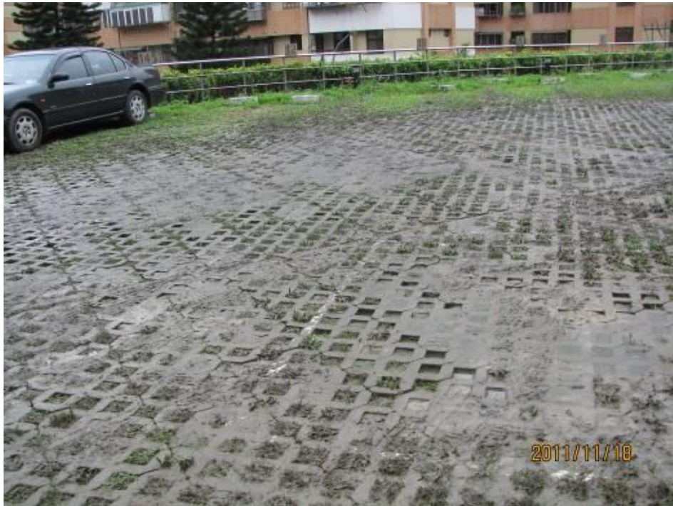
地坪積水泥濘情形-3
