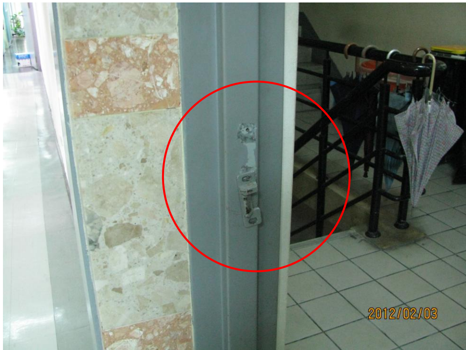
A棟8樓防火逃生門(卡筭鬆脫)
