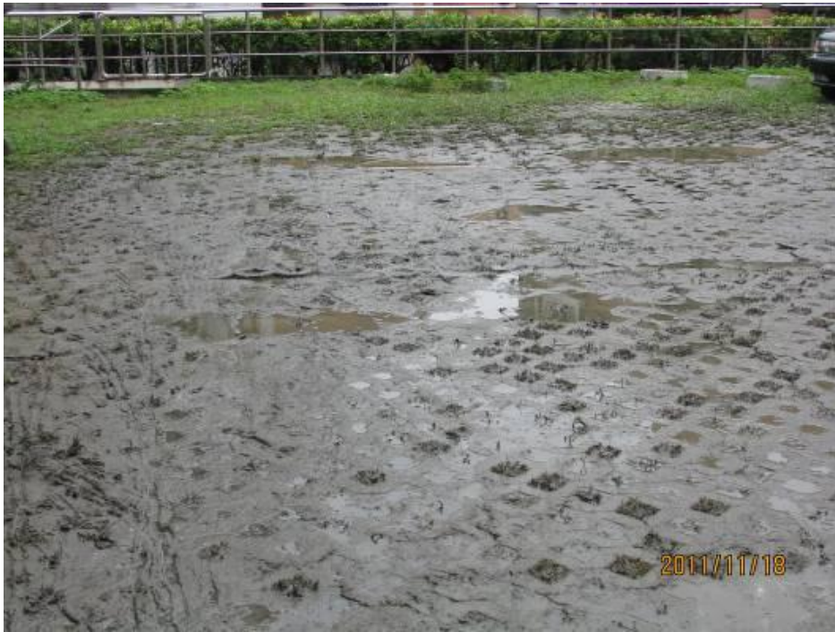
地坪積水泥濘情形-5
