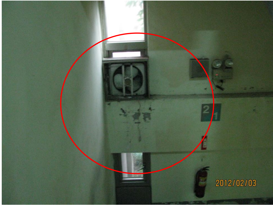
雨水滲入積水及牆面污損—5
