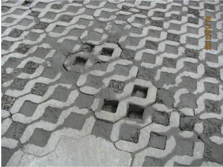
地坪土壤流失淘空-1
