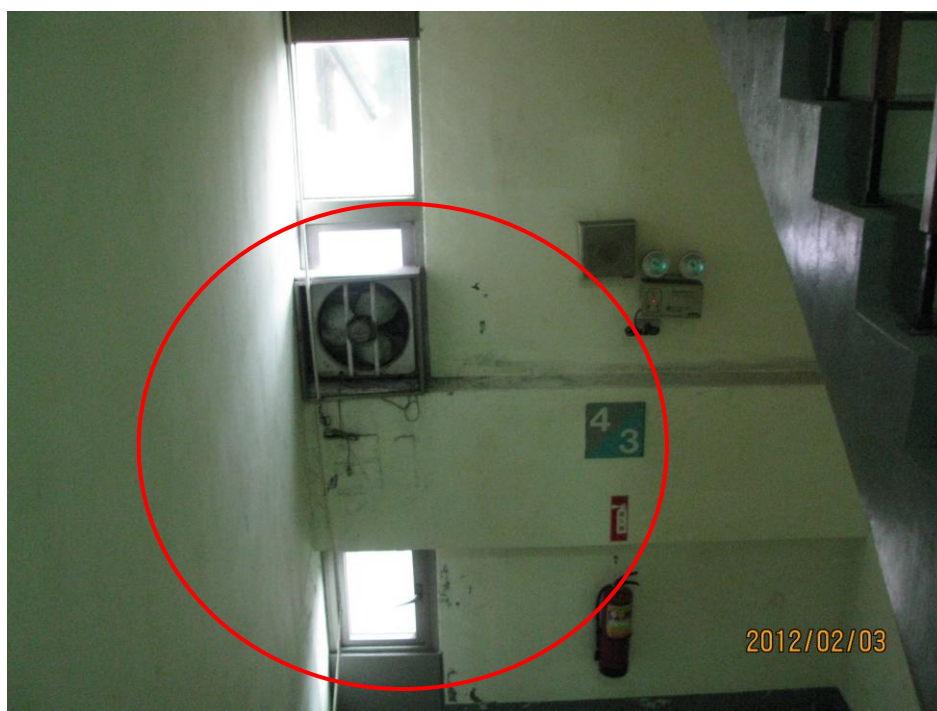
雨水滲入積水及牆面污損—2
