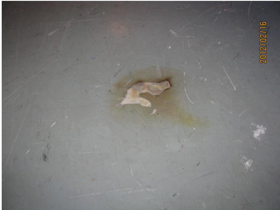
B棟5樓第4攝影棚地板破損(2)
