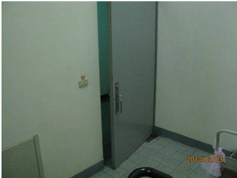
A棟地下3樓防火門(無法閉合)
