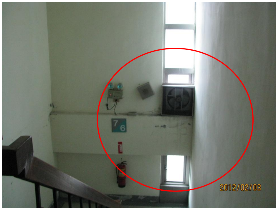
雨水滲入積水及牆面污損—1
