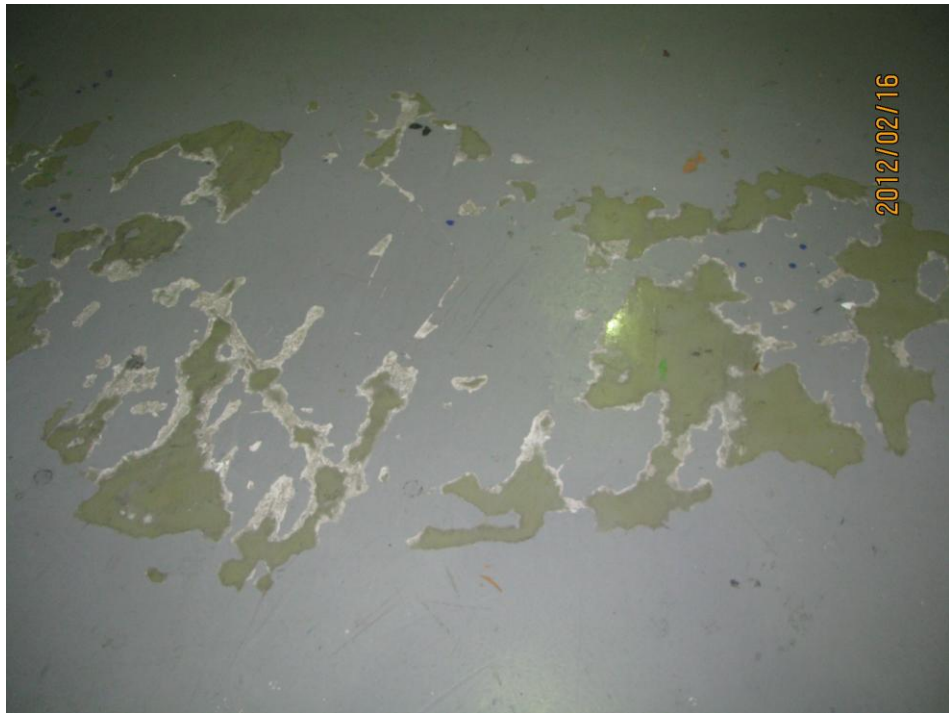
B棟1樓第2攝影棚地板破損(2)
