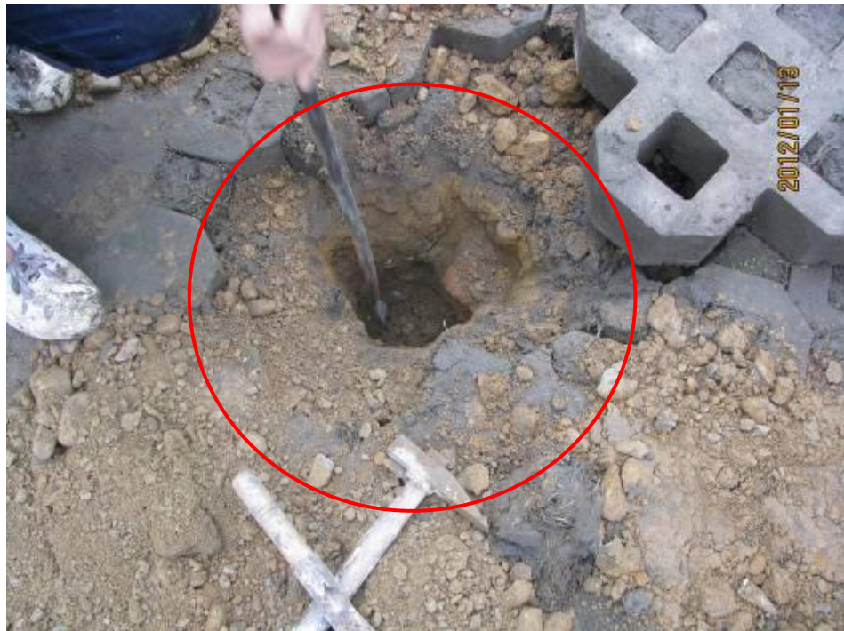
地坪底部防水層破損-2
