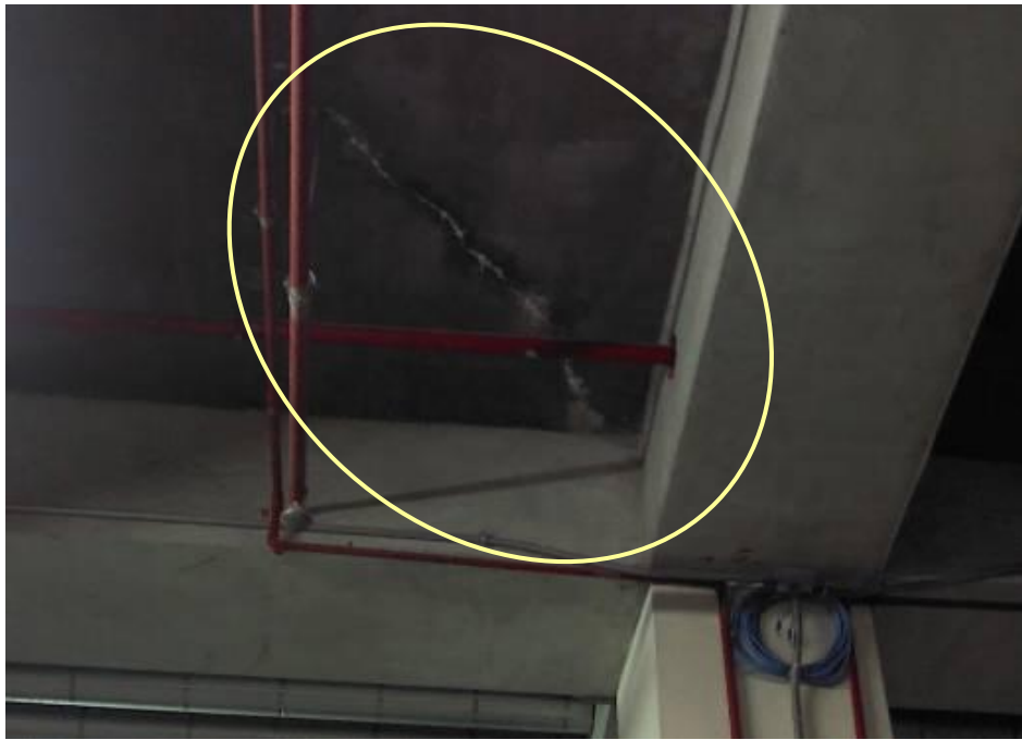
0B 車庫天花板 (停車場下層)-1 (裂縫漏水)
