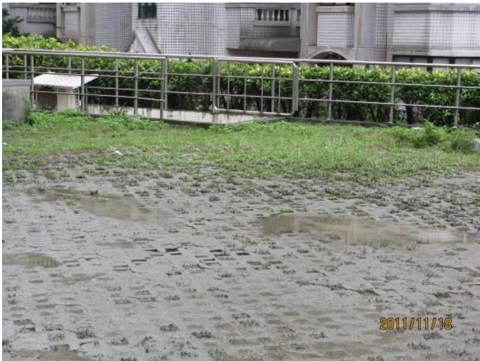
地坪積水泥濘情形-6
