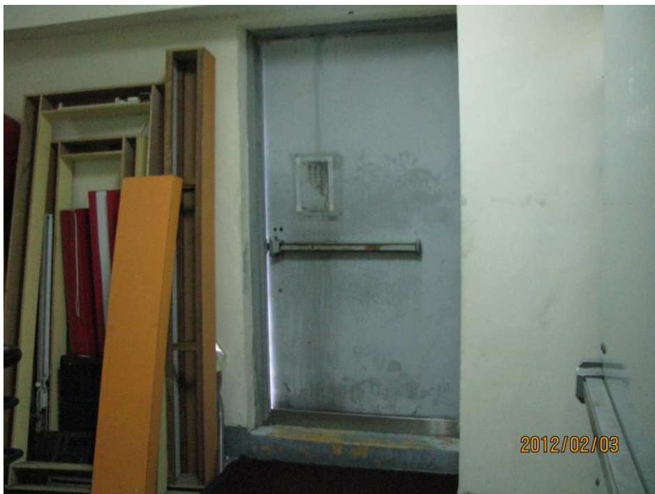
A棟頂樓防火逃生門(無法閉合)-2
