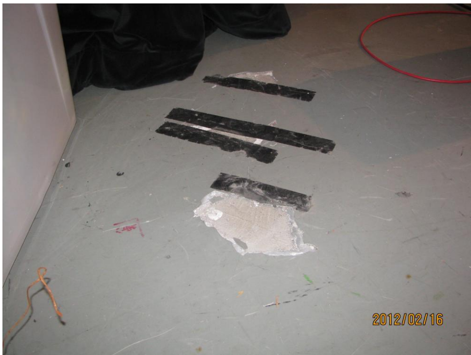
B棟5樓第4攝影棚地板破損(1)
