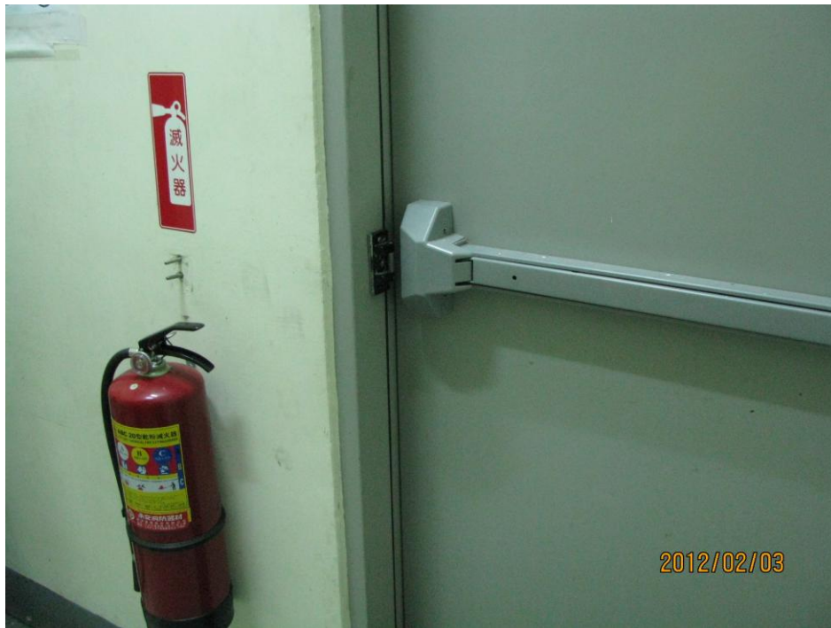
B棟1樓防火逃生門(無法閉合)-2
